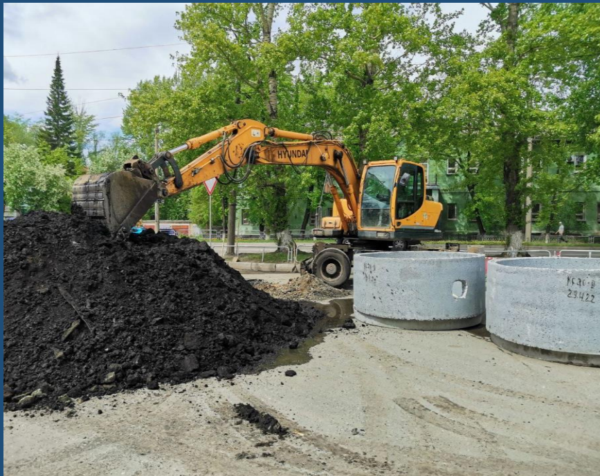
ул. Ленина, реконструкция водоотведения
