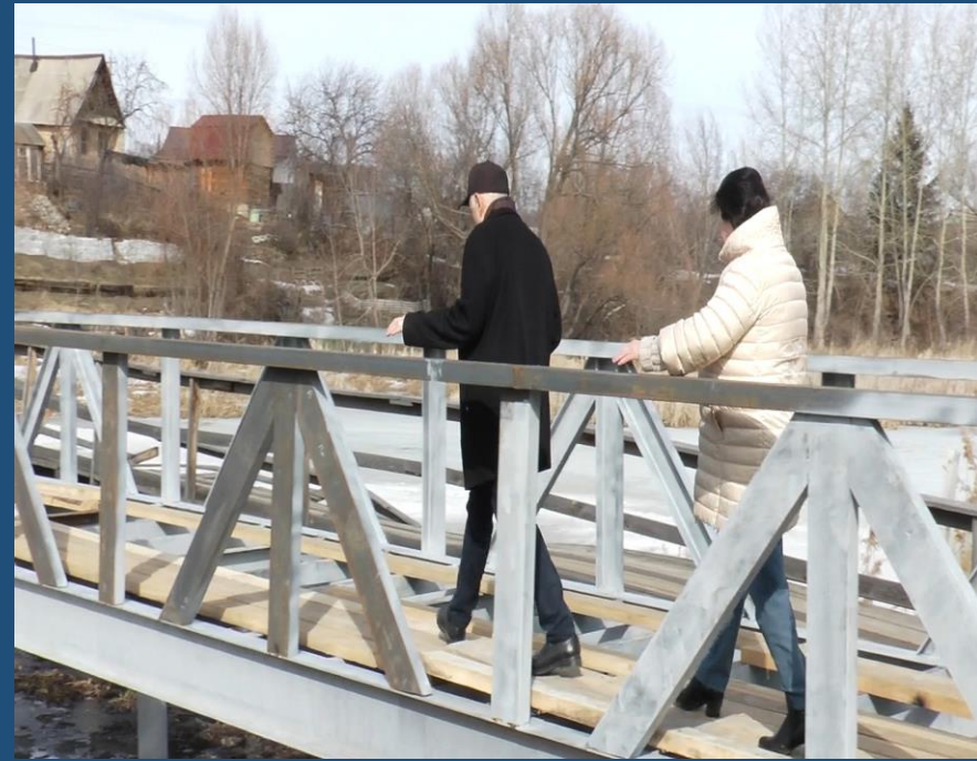
Мост на «Крутоярах», 2022 - 2023 годы
